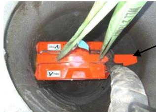
Blocage en position de la machine à l'aide du télescope qui vient en appui sur la paroi intérieure du regard.
