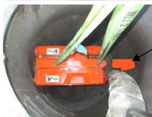
Blocage en position de la machine à l'aide du télescope qui vient en appui sur la paroi du regard.
